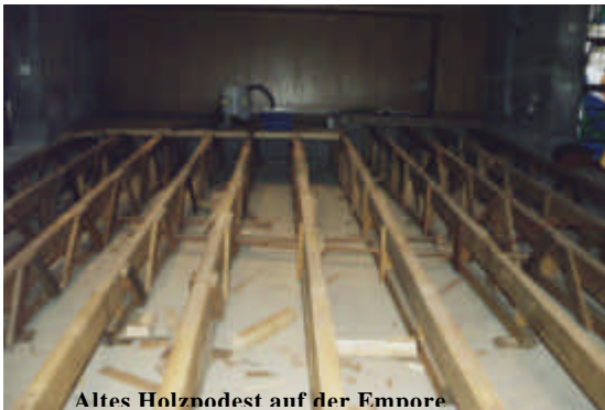
Altes Holzpodest auf der Empore
